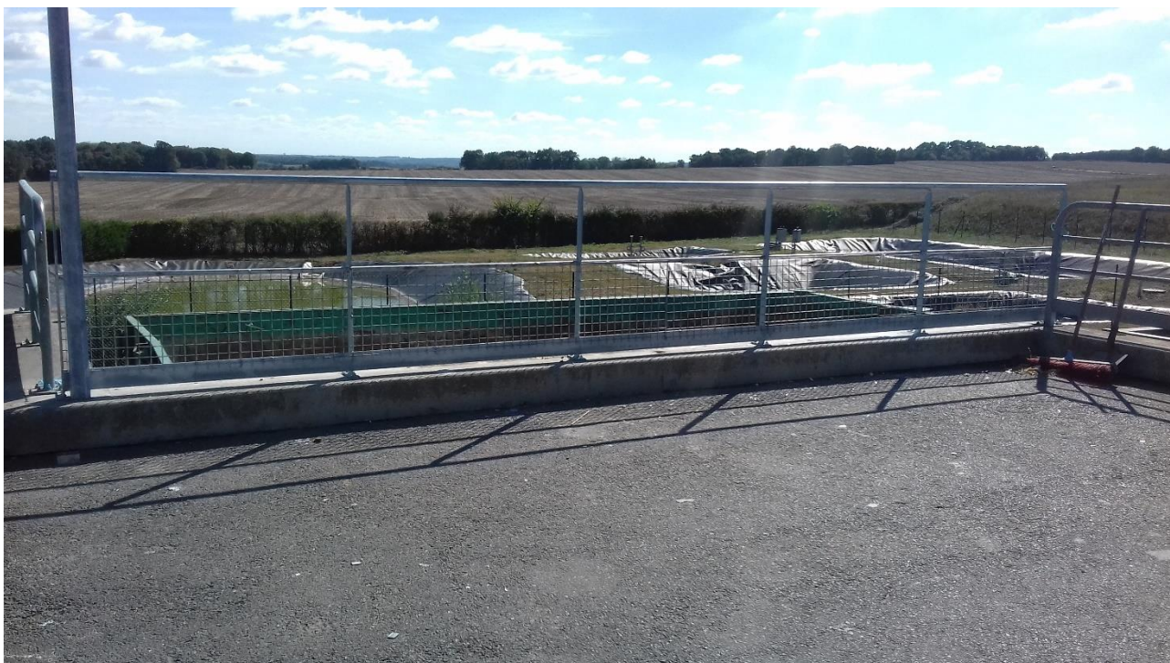
Garde-corps mis en place sur la déchèterie de Bossay-sur-Claise
