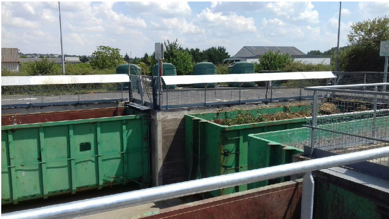
Garde-corps mis en place sur la déchèterie de Descartes.
