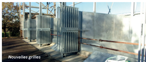
Photo après travaux Nouvelle trémie et filet
