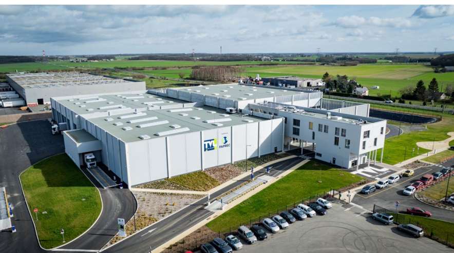
Le nouveau centre de tri interdépartemental de Parçay-Meslay
